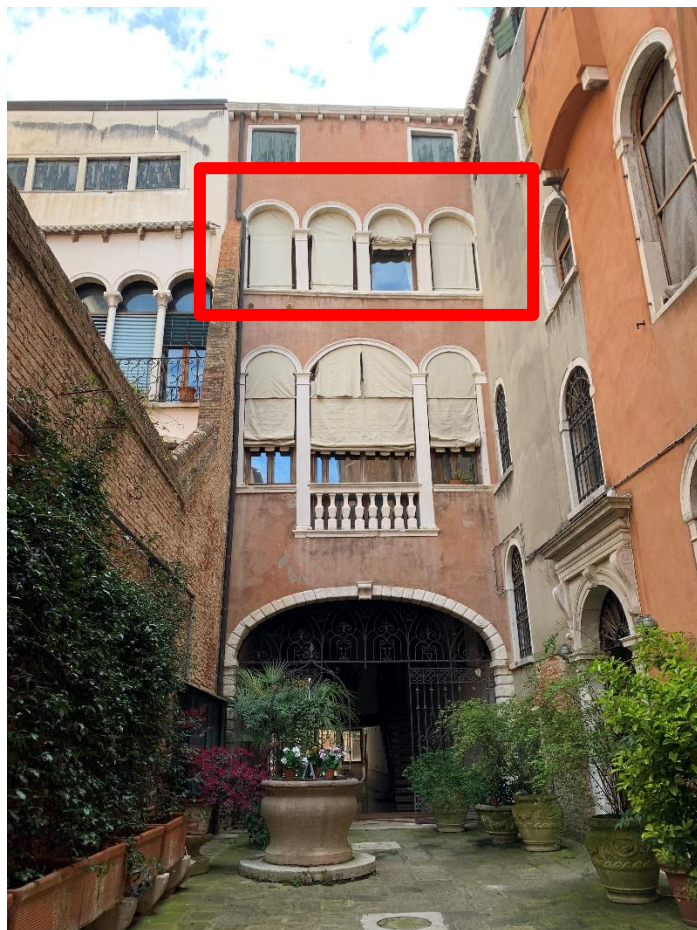
Corte interna comune
