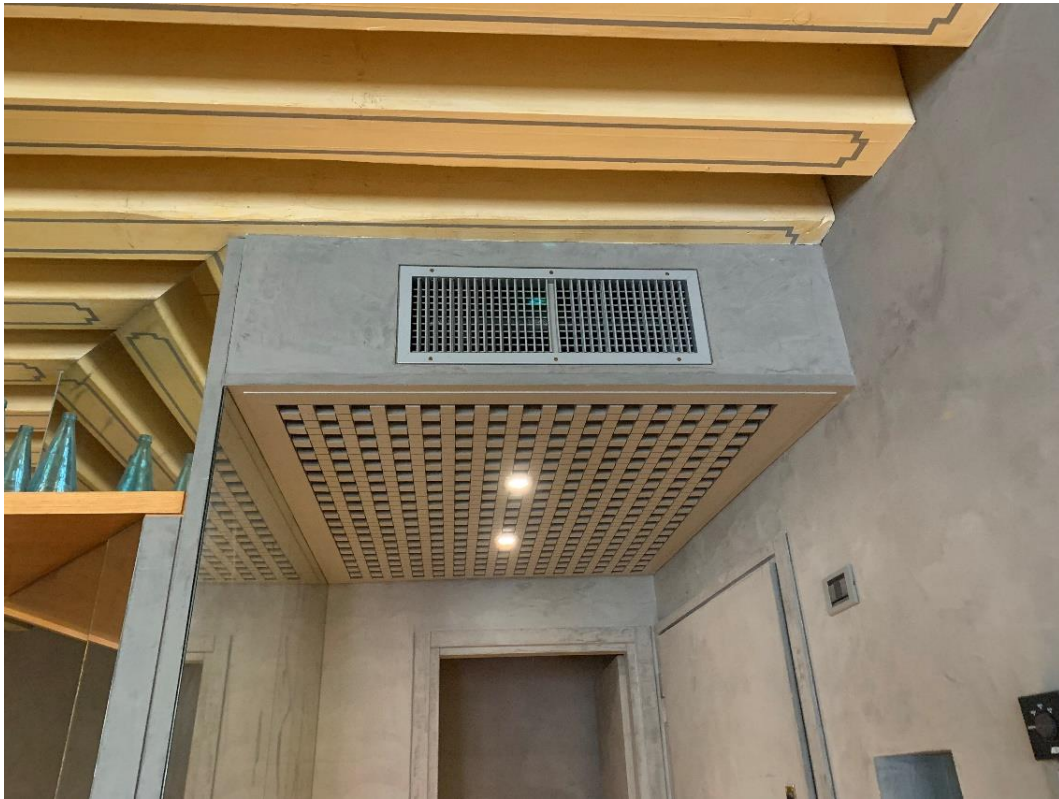
Dettaglio ribassamento solaio per passaggio condotte aria
