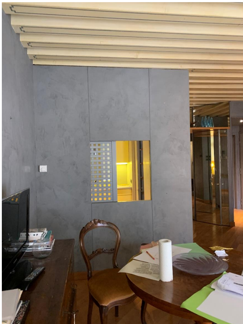
Dettaglio passa vivande tra locale cucina e soggiorno
