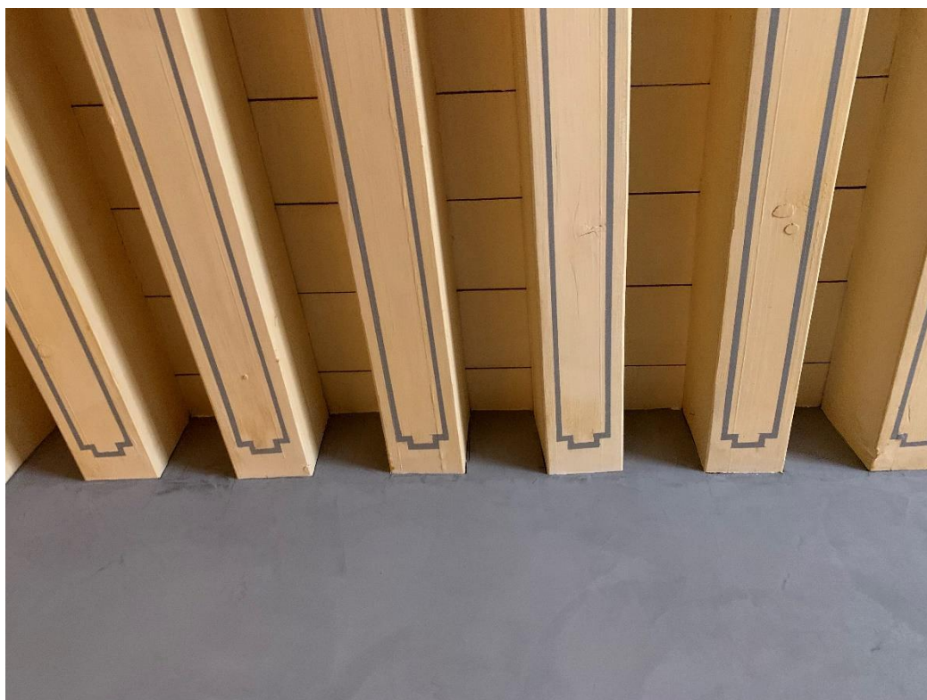
Dettaglio solaio ligneo con travature
