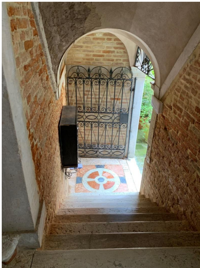
Dettaglio vano scala comune
