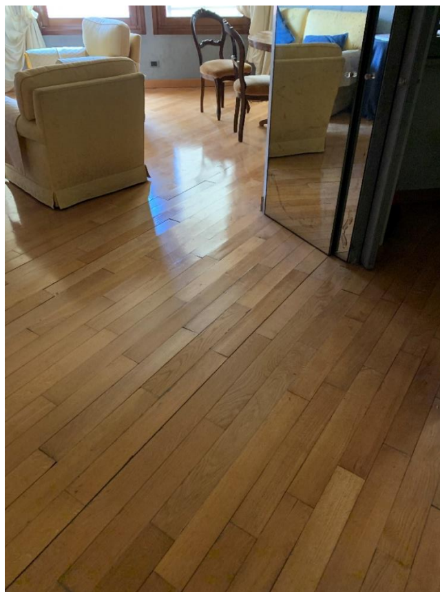
Dettaglio parquet in legno
