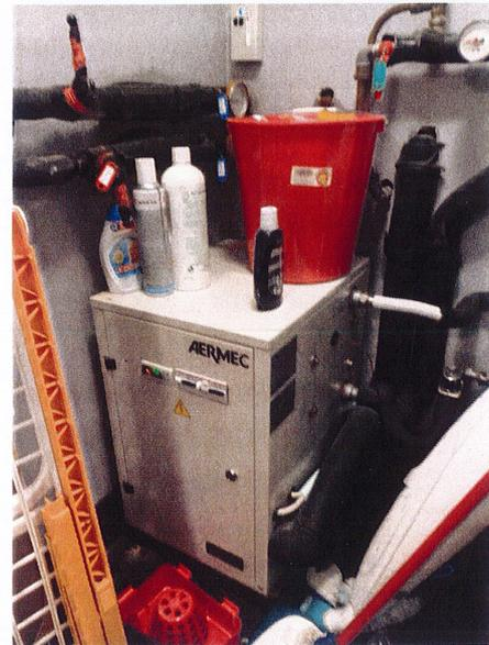
Pompa di calore per riscaldamento e raffreddamento
